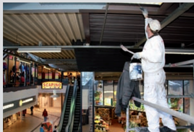
▲ Schilder Jacob de Vries brengt een taupekleur aan op de stalen draagbalken.
