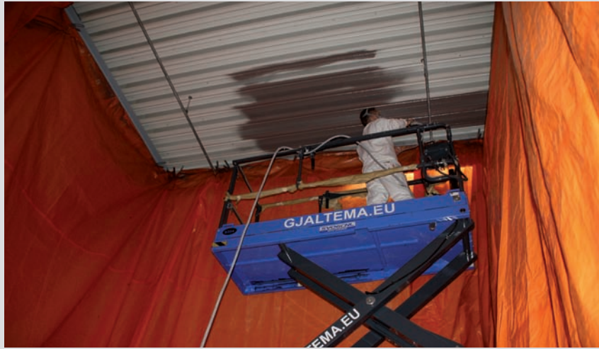
▲ Temidden van winkelend publiek voert Dennis Brouwer, afgeschermd door meterslange zeildoeken, spuitwerk op hoogte uit.
