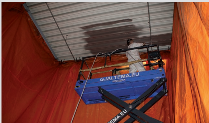
▲ Temidden van winkelend publiek voert Dennis Brouwer, afgeschermd door meterslange zeildoeken, spuitwerk op hoogte uit.
