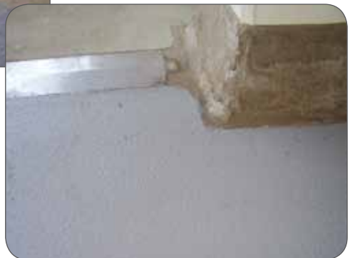
Fig. 10 Uiterlijk Nylo Decofloor BT na het aanbrengen van de tweede laag
