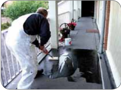
Fig. 11: 1e laag Nylo Decofloor GT
