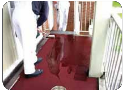
Fig. 14 2e laag Nylo Decofloor GT aanbrengen
