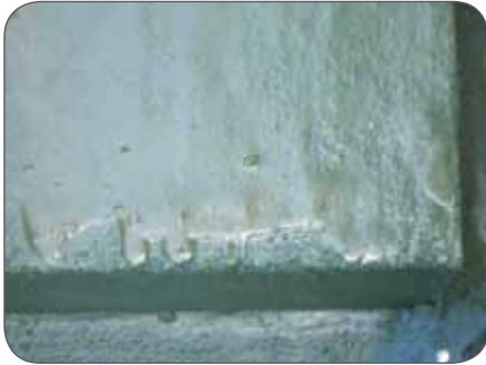
Fig. 19: Gele vlekken door te dikke en onegale toplaag
