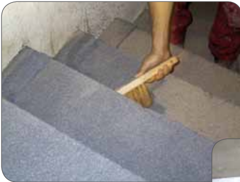
Fig. 9 1e laag Nylo Decofloor BT ingestrooid met kwartsiet 0.3- 0.7 mm. Losse kwartsiet verwijderen
