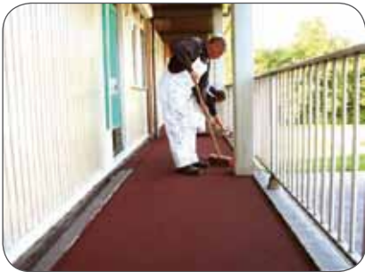
Fig. 13: Na 30 minuten losse Granucol verwijderen.
