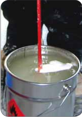
Fig. 8: Machinaal mengen
