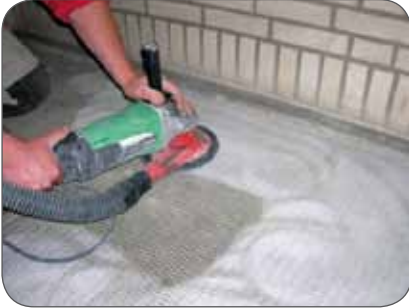
Fig. 6 Handmatig schuren met carborundum schuurschijf
