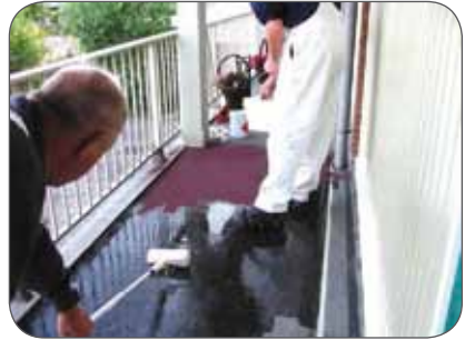
Fig. 12: Natte laag instrooien met Granucol
