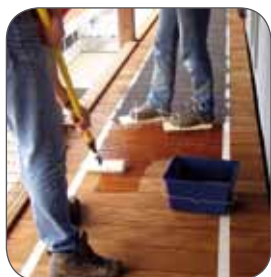
Fig. 14: 1e laag Nylo Decofloor GT
