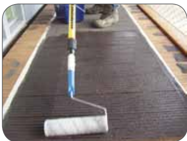
Fig. 17: 2e laag Nylo Decofloor GT
