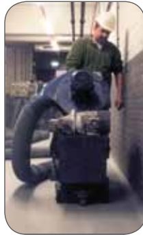
Fig. 7 en 8: Stofvrij stralen en droog stralen
