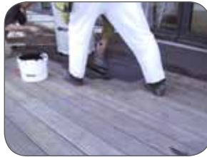
Fig. 11: Aanbrengen Nylo Bruggencoating
