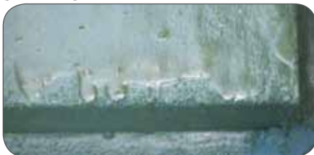
Fig. 25: Gele vlekken door te dikke en onegale toplaag
