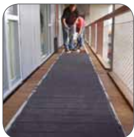
Fig. 15: Natte laag instrooien met Granucol
