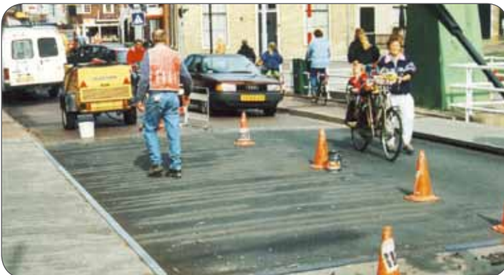
Fig. 23: Na ca. 30 minuten kan het brugdek worden belast
