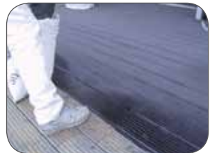
Fig. 12: Instrooien met Korund fijn
