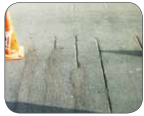
Fig. 22: Nastrooien met Korund fijn
