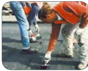
Fig. 21: Aanbrengen Nylo Decofloor BT
