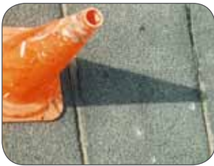
Fig. 20: Brugdek voor reparatie
