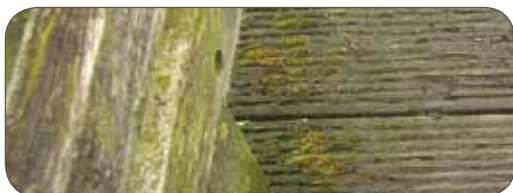
Fig. 6: Alg- en mosaangroei op onbehandeld brugdek
